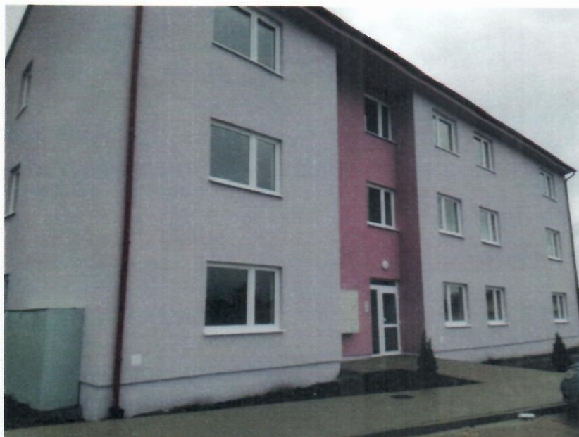
Bytové domy – Dolný Bar, 24 bytových jednotiek, r. 2018 - 2019
